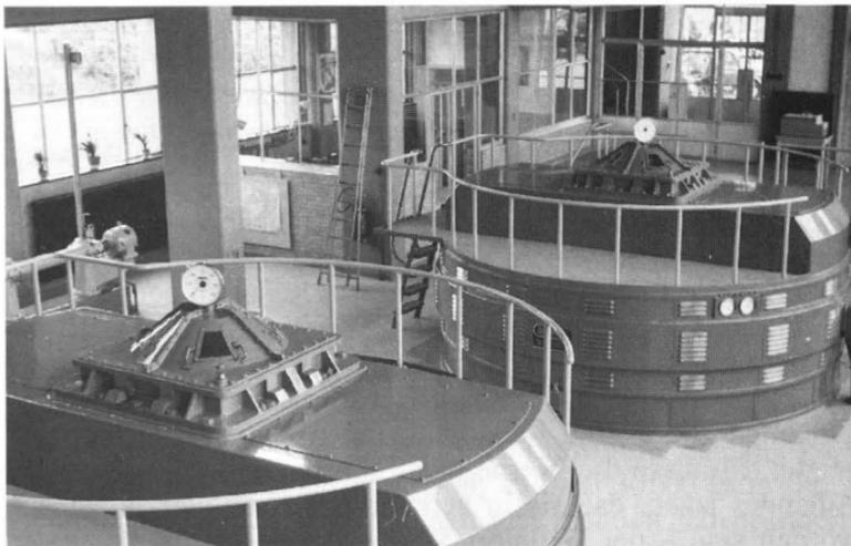
Die zwei Pumpen des Schöpfwerkes „Lovink“ bei Harderwijk werden durch Elektromotoren angetrieben. Jede Pumpe hat eine Kapazität von 580 m<sup>3</sup>/min.
