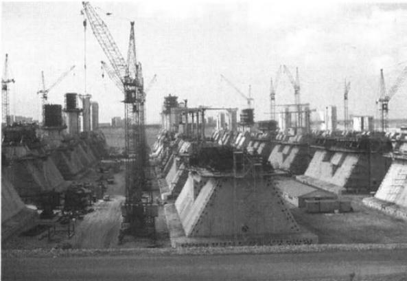
Die Baugrube in der Oosterschelde 1981. Hier werden die Pfeiler für das Absperrwerk hergestellt und dann versetzt.
