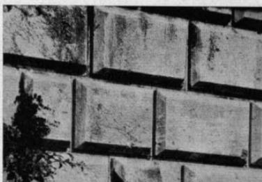
Abb. 3: Kalksteinquader von den Turmunterbauten
